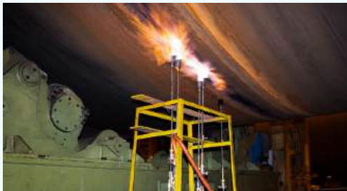
改进后的单桩焊接预热工艺
